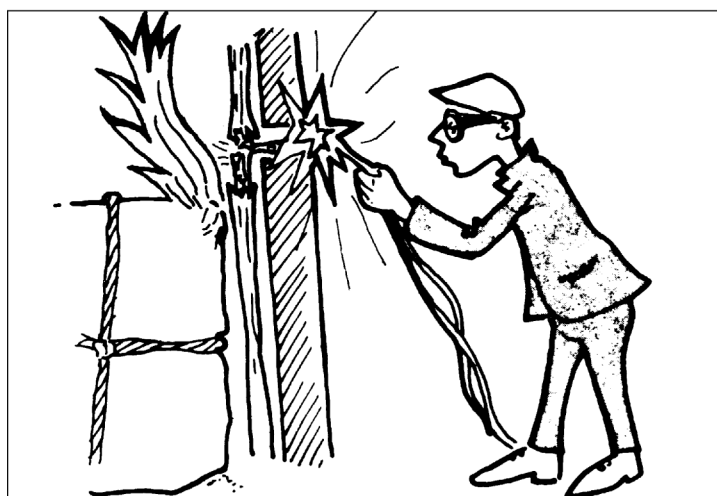
Fig. 2 - INFLAMMATION AU CONTACT DE CONDUITES INVISIBLES CHAUFFÉES
